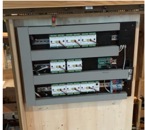
Die neue SPS-Anlage, die die Orgel steuert Foto: J. Kiene
